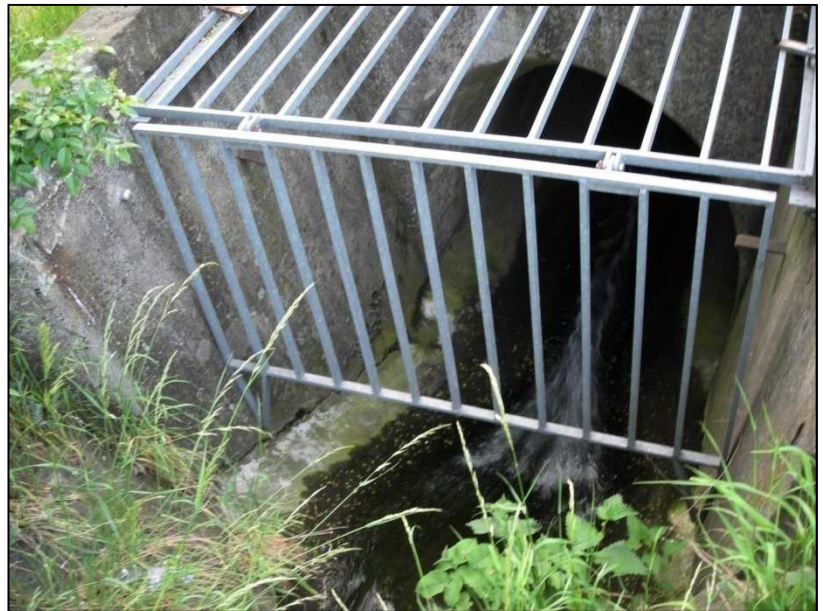
Abbildung 5-19: Unterführung Dohnaer Straße
