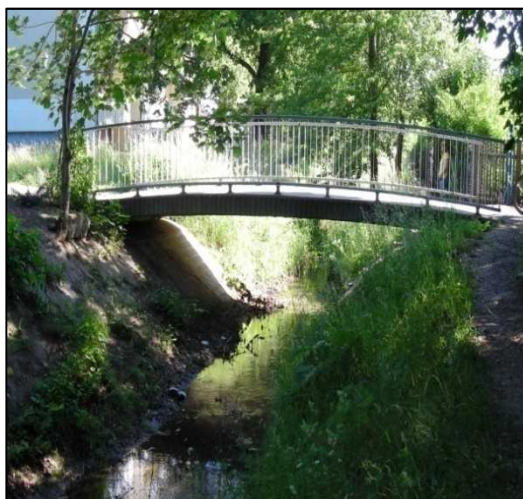
Abbildung 5-5: Beispiel für ein Bauwerk mit bogenförmiger Konstruktion (Brücke Liebstädter Straße Höhe Rothermundtpark)
