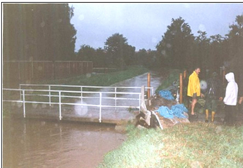
Abbildung 3-6: Brücke Kleinhausweg während des Hochwassers 08/2002 (Quelle: GEOS, 2006a)
