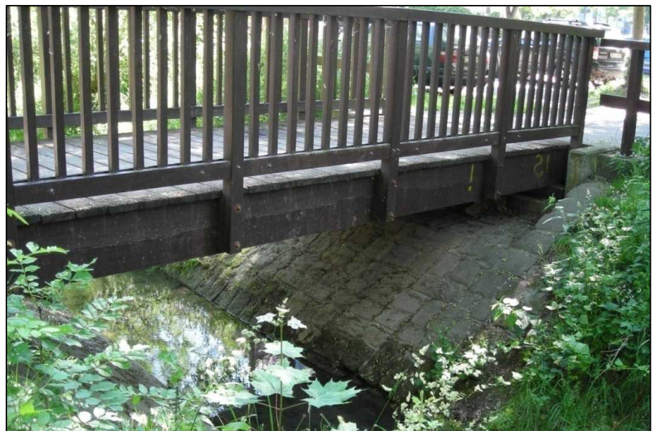
Abbildung 5-23: Brücke „Kipsdorfer Straße“
