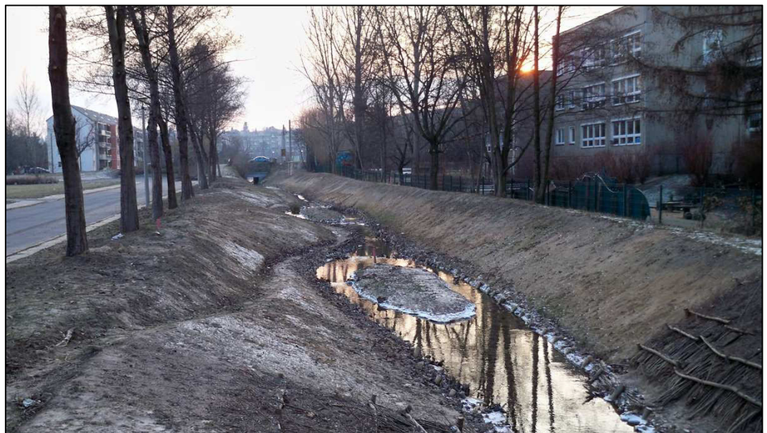
Abbildung 7-24: Neu gestalteter Gewässerabschnitt in Reick (ca. Fluss-km 4,500) von der Brücke Höhe KiTa Spielekiste e. V. zur Reicker Straße (Blick flussaufwärts)
