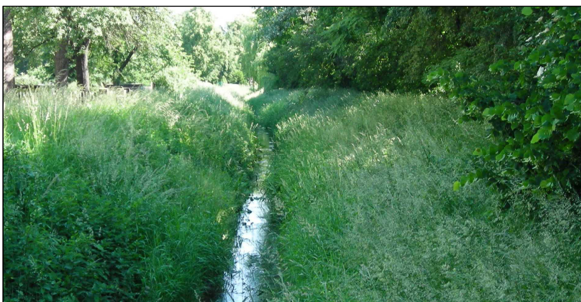
Abbildung 7-33: Deichabschnitt am Fluss-km 2,000 mit Blick von der Brücke Hepkestraße (Blick flussabwärts)
