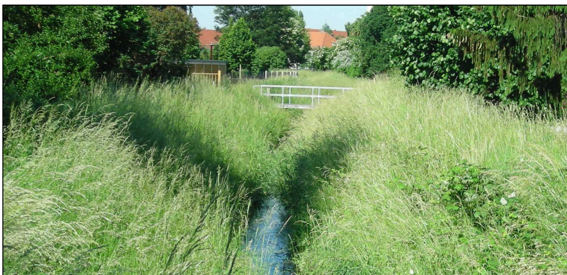
Abbildung 7-32: Deichabschnitt am Fluss-km 2,260 mit Blick von der Brücke Kleinhausweg (Blick flussabwärts)
