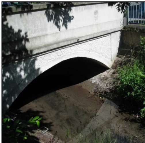
Abbildung 5-4: Beispiel für ein Bauwerk mit Kreisprofil (Brücke Heinrich Schütz-Straße)
