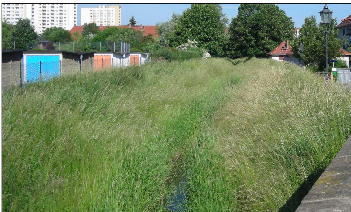
Abbildung 7-30: Deichabschnitt am Fluss-km 2,492 mit Blick von der Brücke Frauensteiner Platze (Blick flussaufwärts)
