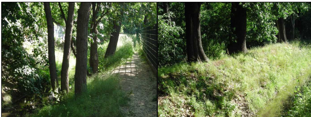
Abbildung 7-28: Deichabschnitt ca. am Fluss-km 3,080 (links) und ca. am Fluss-km 2,970 (Blick flussaufwärts)
