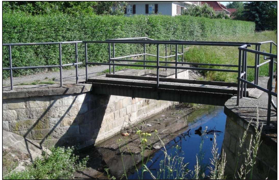
Abbildung 5-20: Brücke „Am Grüngürtel“
