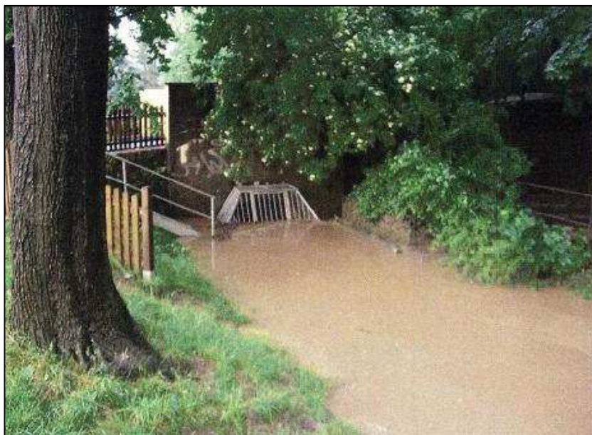
Abbildung 3-2: Mit der Verkläuerung verbundener Aufstau (Quelle: VEHMANN (2008))
