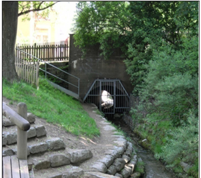
Abbildung 3-4: Schutzgitter an der Heiligenbornstraße unterhalb des Spielplatzes Heiliger Born bei normaler Wasserführung im Juni 2011
